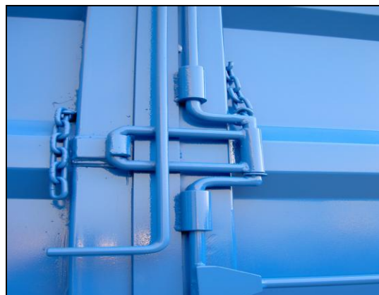
Detalle de puerta tipo libro y cierre de seguridad
